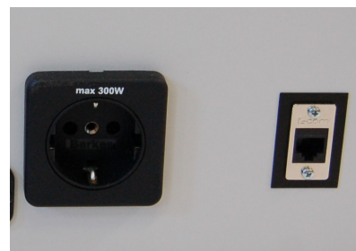
LAN konektor kot dostopna točka za router
