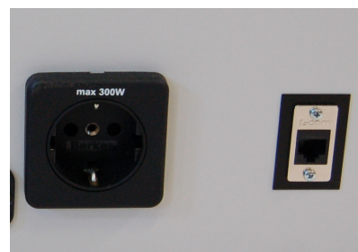
LAN konektor kot dostopna točka za router
